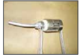
Den Aluschlauch mit einem 11mm verstellbaren Schraubenschlüssel aufdrehen
